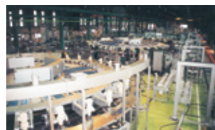
ブラウン管設備
