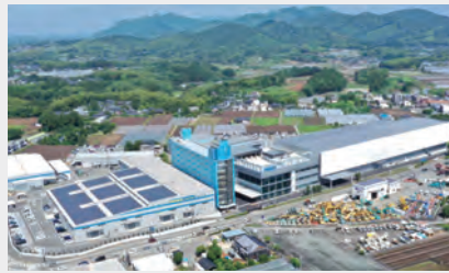
本社／熊本工場
