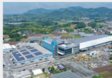
本社／熊本工場
