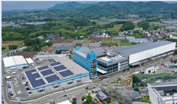
本社/熊本工場 ※青ビル(中央)の右が Headquarters Building
