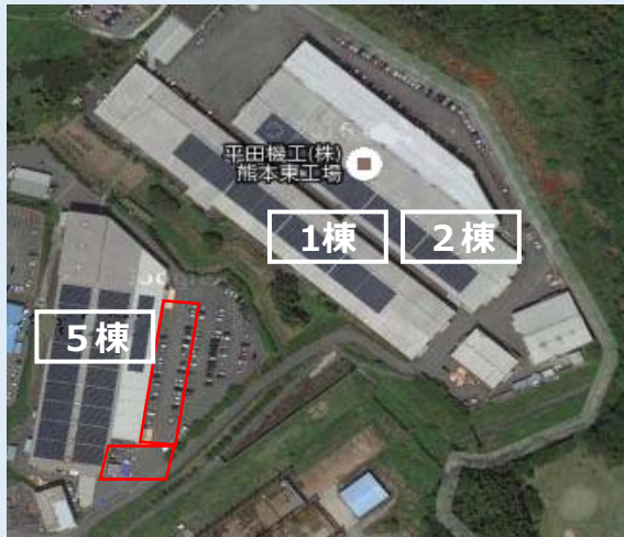
工場増設予定地：熊本市北区植木町（赤枠部分）
