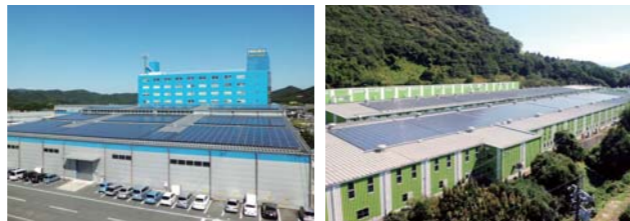
熊本工場(左)、熊本東工場に設置された太陽光パネル
