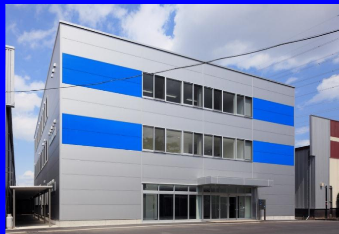
関東工場の技術センタービル
