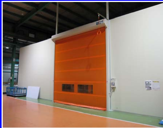
クリーンルーム外観
