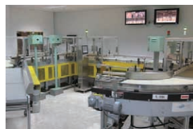
タイヤ材料用ゴム搬送設備
