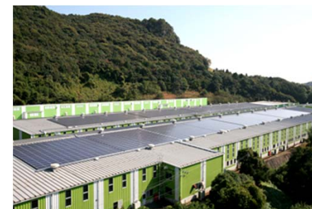
熊本東工場 発電容量600kW
