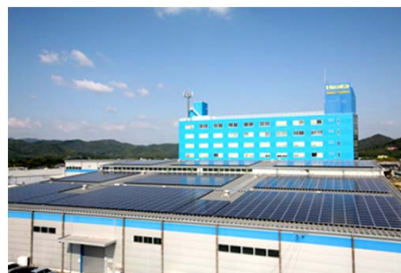
熊本工場 発電容量400kW
