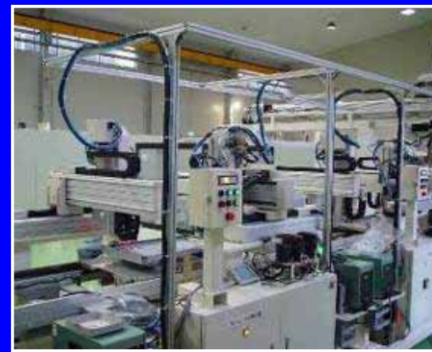
薄型テレビ自動組立設備
