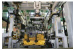
エンジン組立設備
