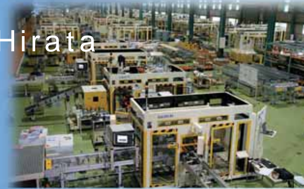
当社で試運転している生産システムの様子
