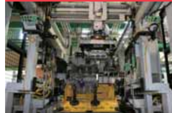
エンジン組立設備
