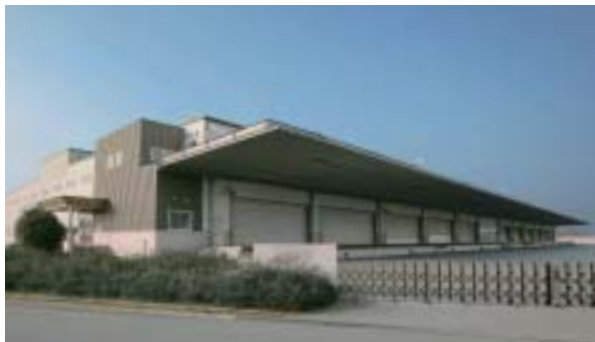
平成20年4月より稼働を開始した七城工場
