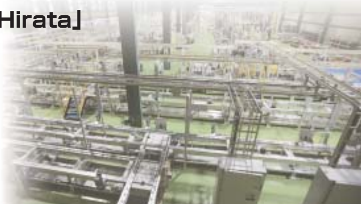
当社で試運転している生産システムの様子
